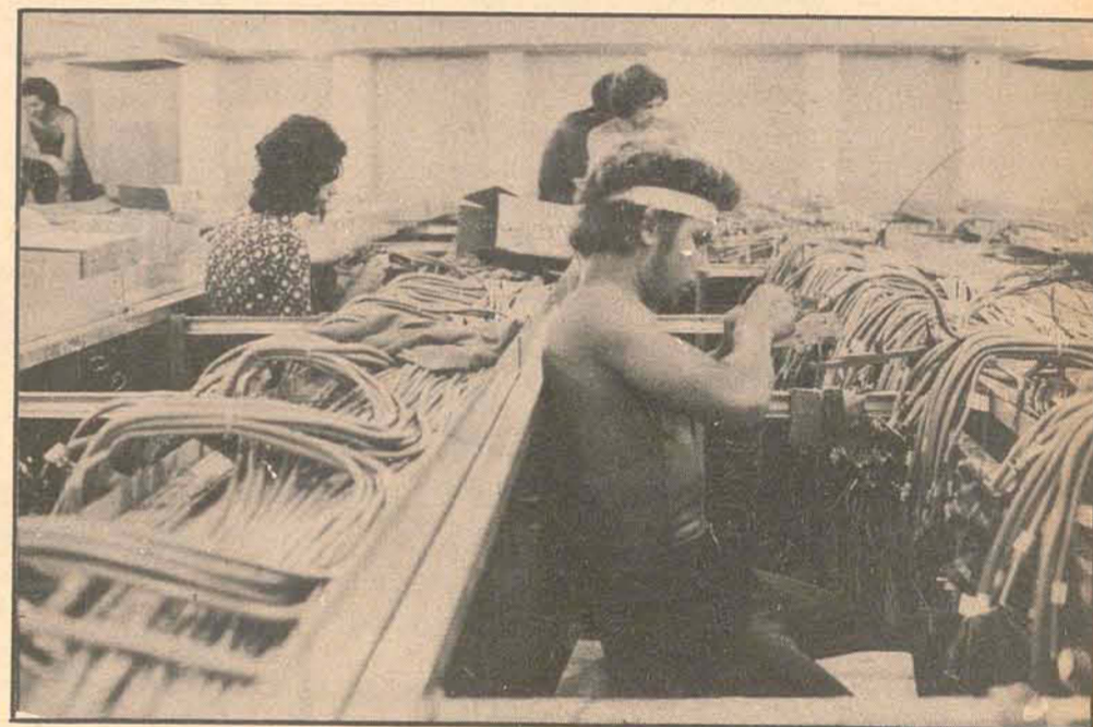
Na nova Central serão utilizados 80 mil metros de cabos, que já estão sendo instalados
