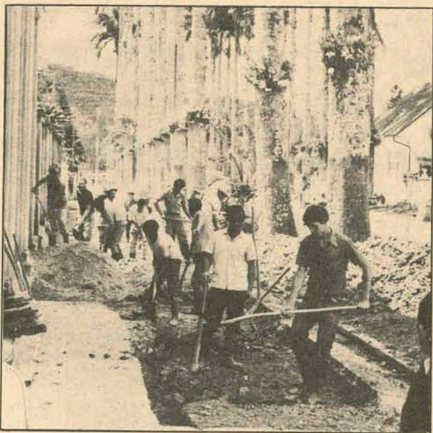
Nas obras do bulvar, a mão-de-obra é qualificada.
