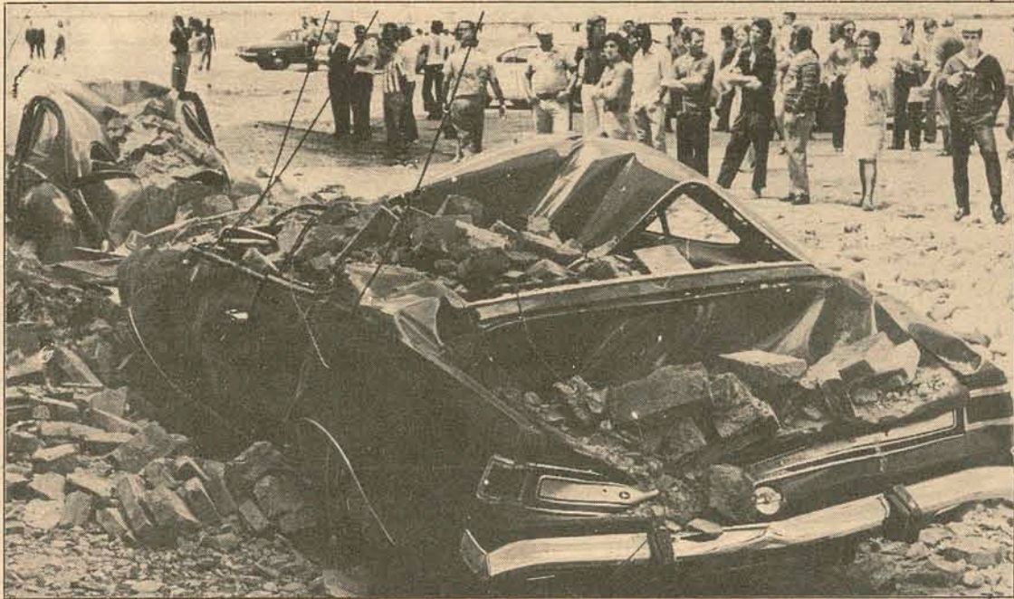
Se o prédio ruísse num dia de semana, poderia causar um acidente de graves proporções.
