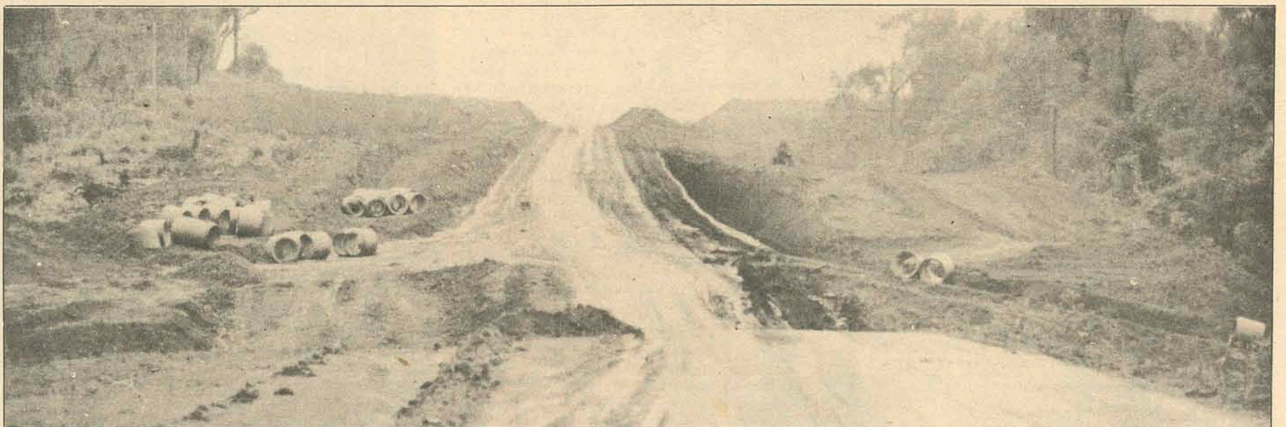
A terraplanagem está pronta. Em março a rodovia estará concluída.
