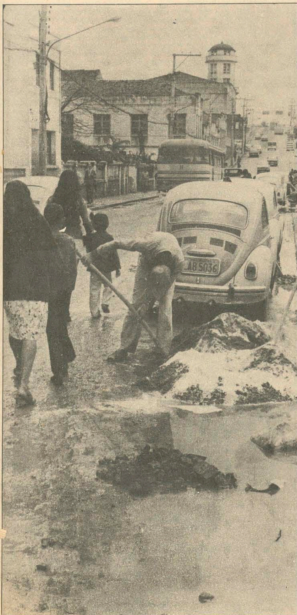
As obras tomam toda a calçada, obrigando os pedestres a andarem pela rua.
