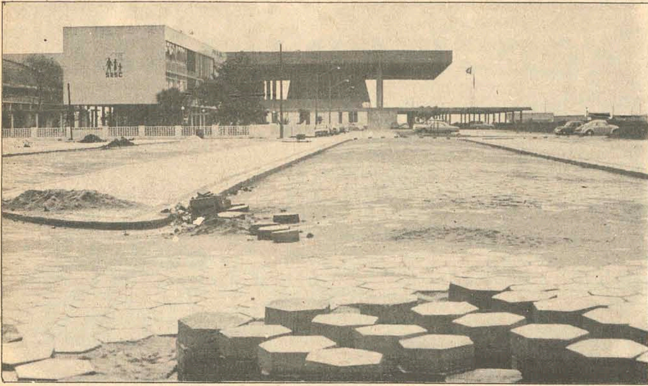
O terminal em construção poderá fornecer abrigos e estacionamentos para 24 linhas
