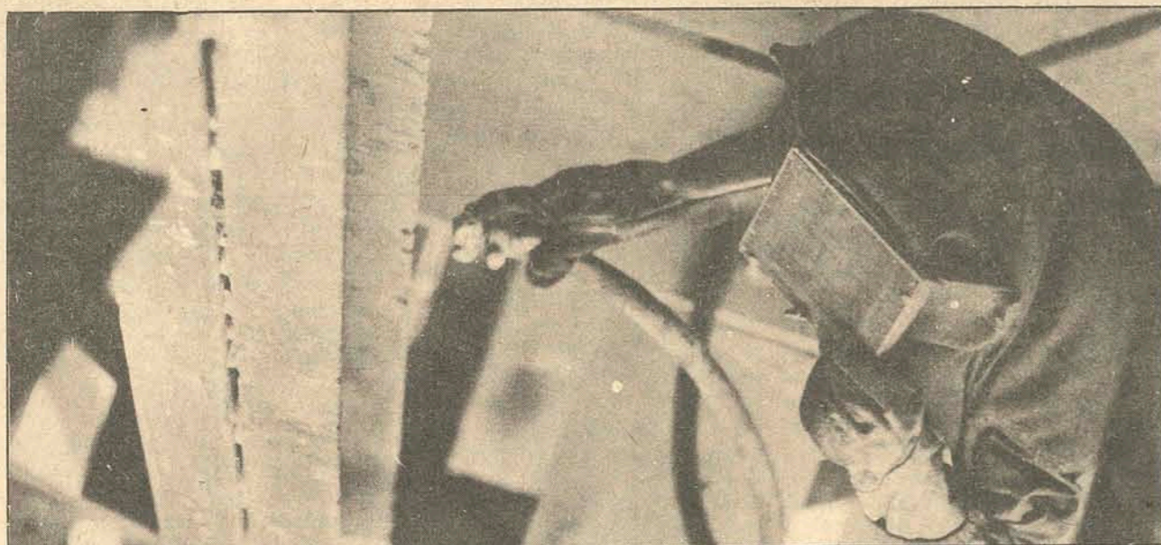
No cuidadoso trabalho de conservação, de 1958 até hoje já foram trocados mais de 500 mil rebites da ponte.
