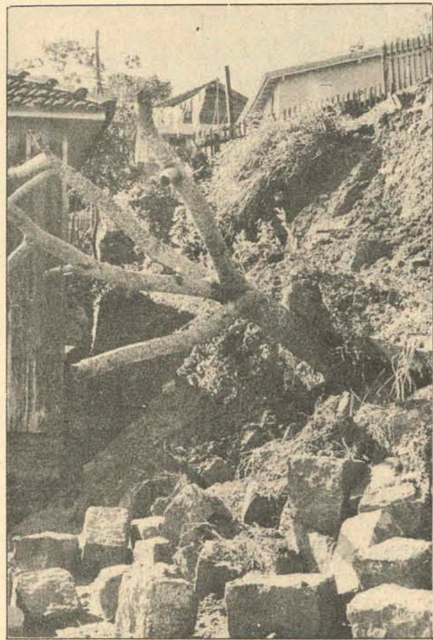
A Erosão ameaça a segurança dos barracos.
