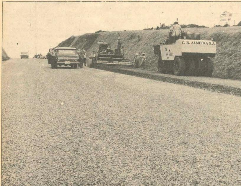
Execução de base em brita densamente graduada, na qual será lançada o concreto asfáltico.
