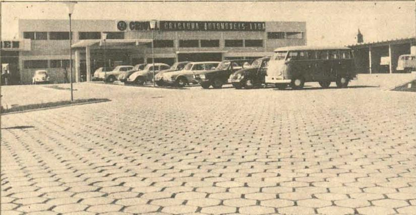
BLOKRET, a moderna pavimentação articulada de concreto vibro-prensado, foi implantada no Pátio da CRIVEL-Criciúma Automóveis Ltda, numa área aproximada de 3.000,00 m<sup>2</sup>.
