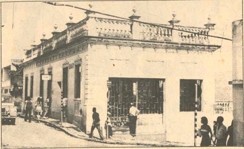
Prédio foi totalmente destruído pelo incêndio registrado ontem.
