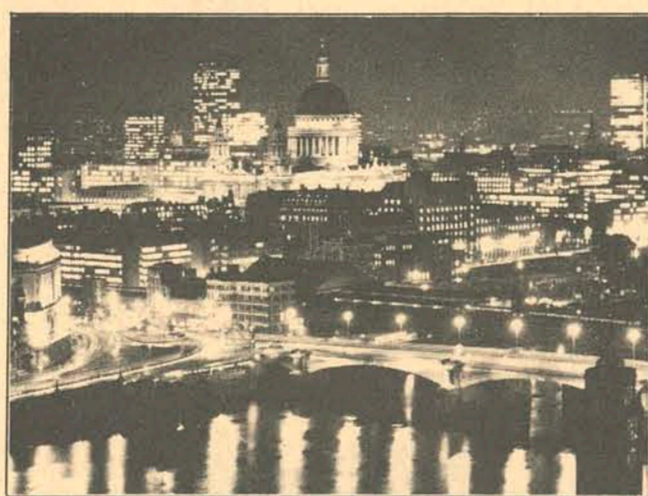
A iluminada Catedral de São Paulo destaca-se dentre as luzes circundantes da "City" de Londres.
