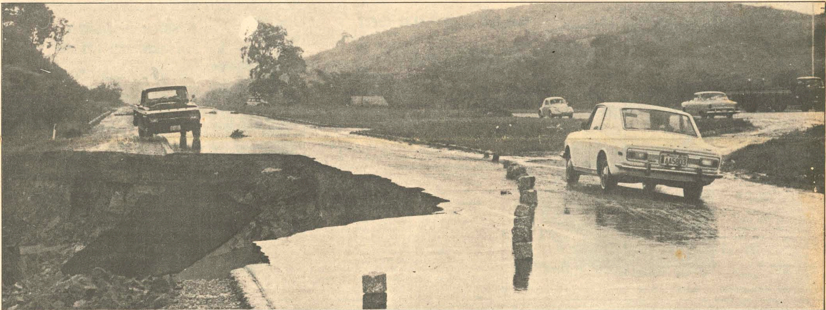
Na localidade de Sorocaba - quilômetro 253 da BR-101 - as águas da chuva levaram consigo mais de 30 metros da pista direita, tornando o tráfego de veículos altamente perigoso.
