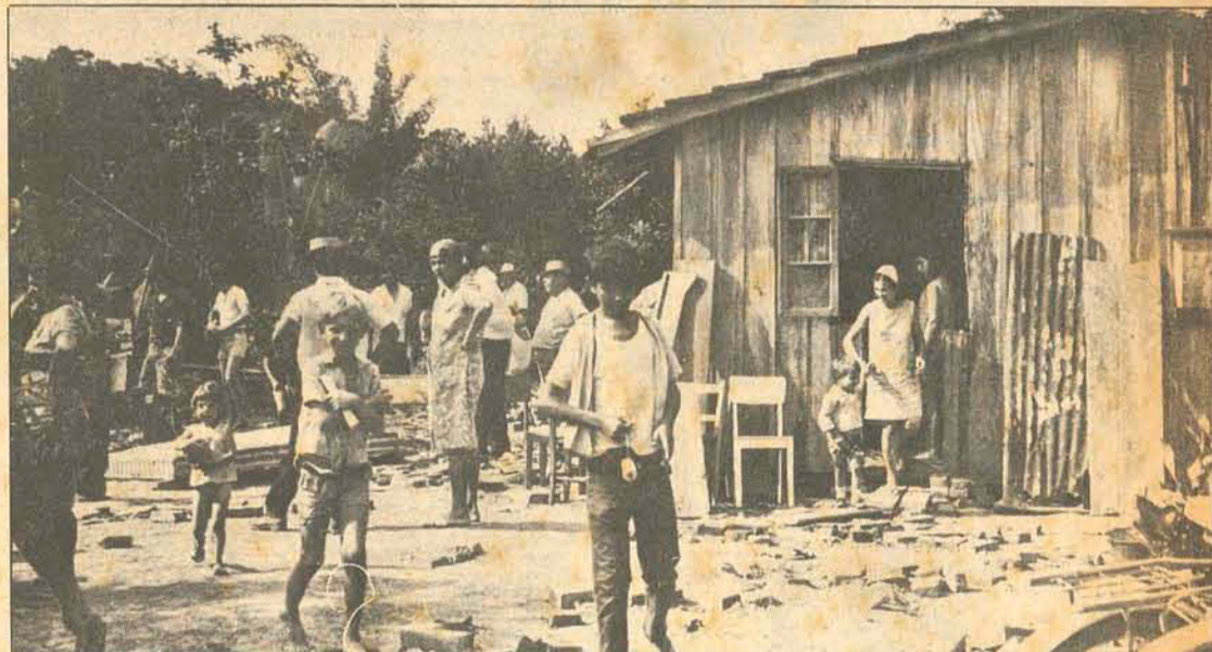
Dos destroços deixados pelas águas, um duro trabalho de reconstrução.
