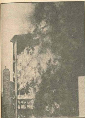
Foi concluído o inquérito sobre o incêndio do Edifício Andraus, em São Paulo, e os peritos concordaram em que o fogo teve início devido a um fenômeno termo-elétrico. Segundo estas conclusões, a cobertura isolante dos condutores elétricos se inflamou, atingindo rapidamente o madeirame e os cartazes a marquise, materiais de fácil combustão. Além desta circunstância, o forte vento que soprava na ocasião favoreceu a ascensão das chamas aos andares superiores.
