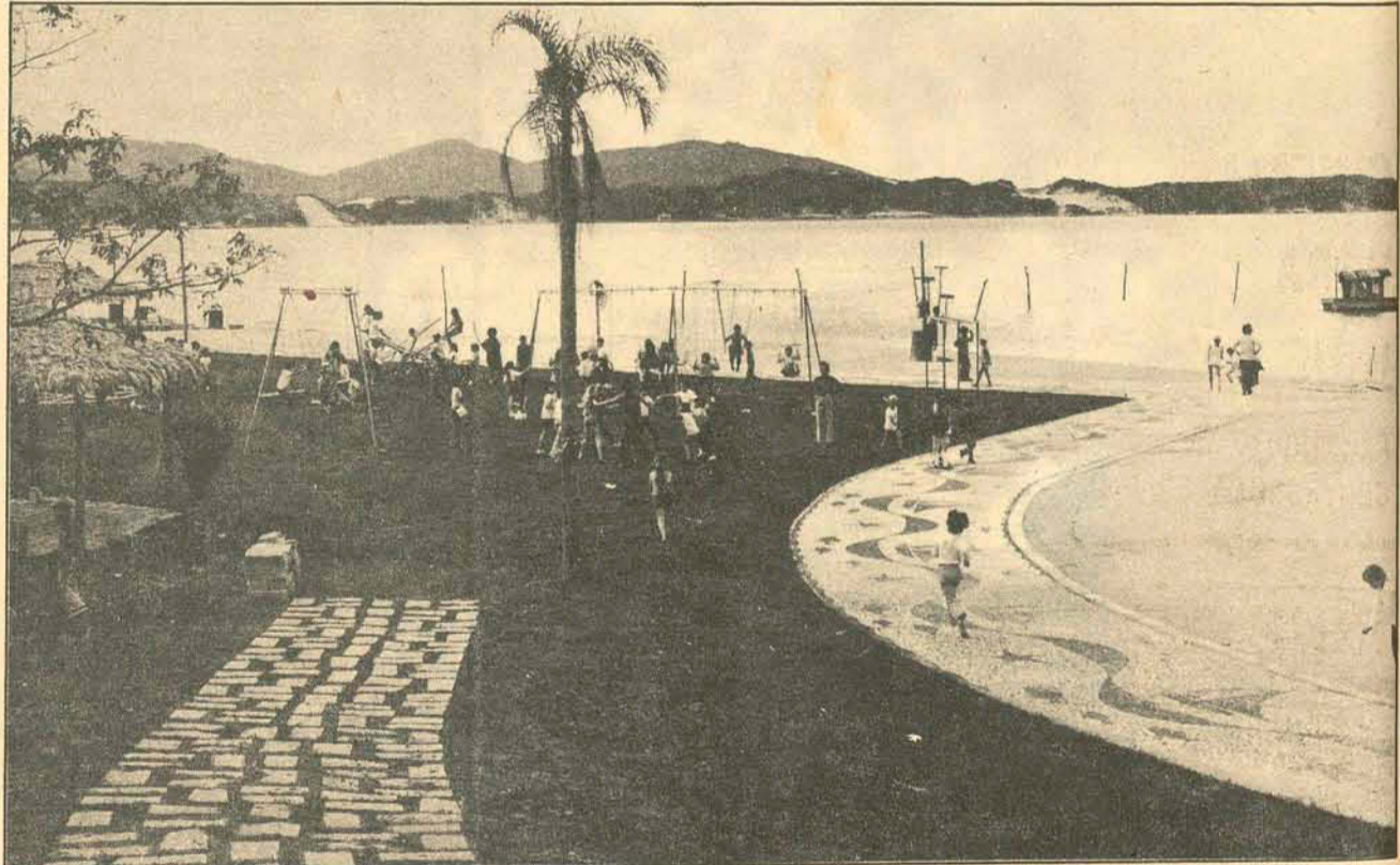
Lagoa Iate Clube - piscinas quase prontas.
