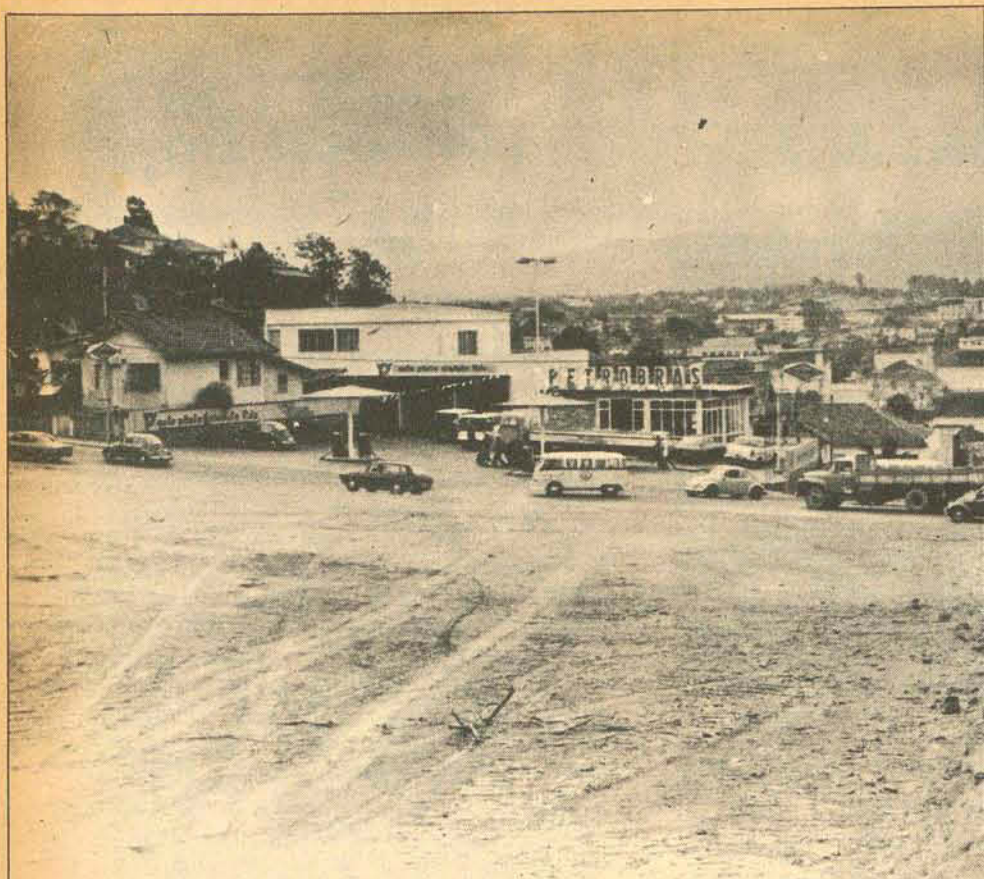
O desmonte nas proximidades da ponte vai facilitar o tráfego dos veículos.
