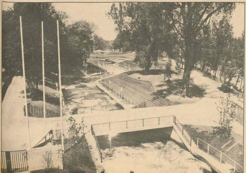
À esquerda, a raia de canoagem dos Jogos Olímpicos. Nos seus 600 metros de comprimento foram construídos 35 blocos de concreto, colocados de tal forma que a água, ao passar por eles forma corredeiras, redemoinhos e outras formas de dificuldades. À direita o "eight" alemão que está sendo preparado por Karl Adam em um lago das montanhas Austríacas. A Alemanha é favorita no remo às medalhas de ouro.
