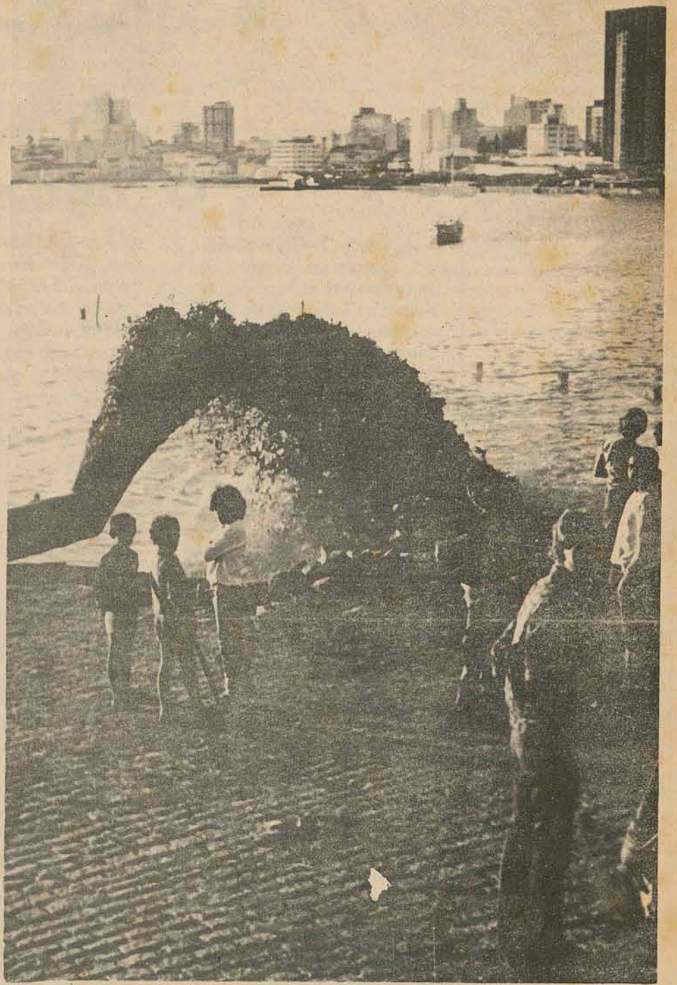
Os tubulões jogam perto do Veleiros o lodo do Tipitinga, provocando o mau cheiro.
