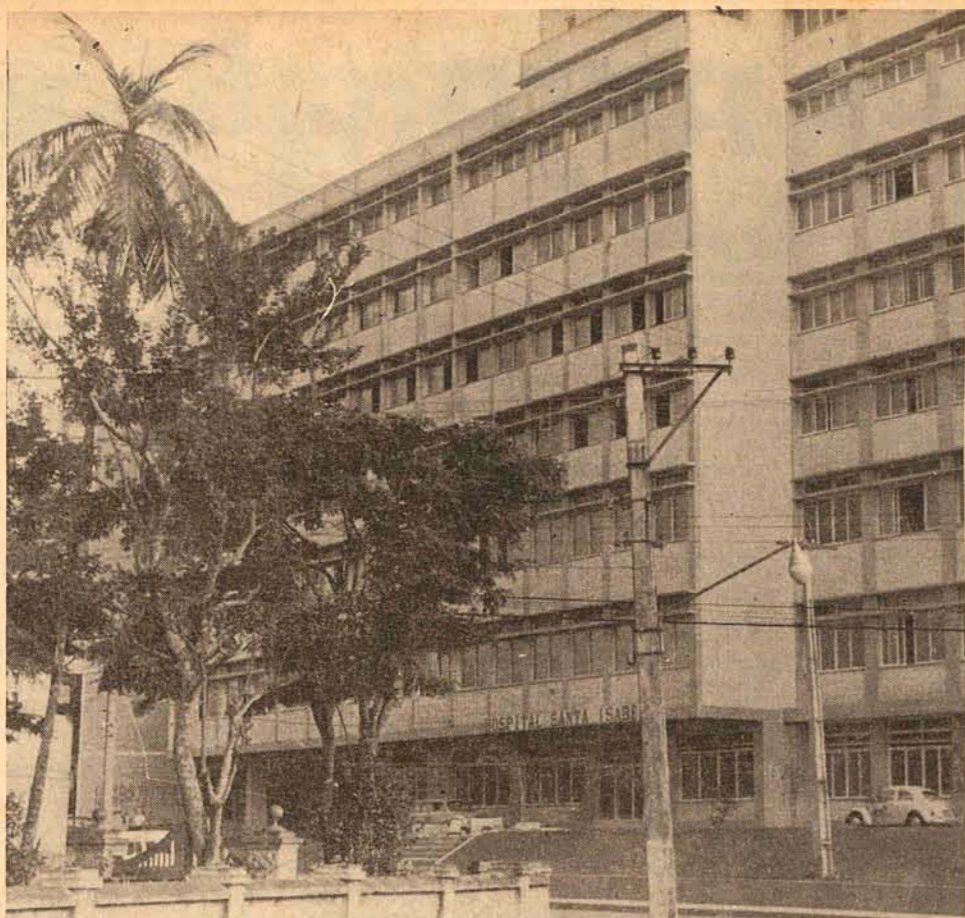
As novas e modernas instalações do Santa Isabel serão inauguradas a 14 de julho.
