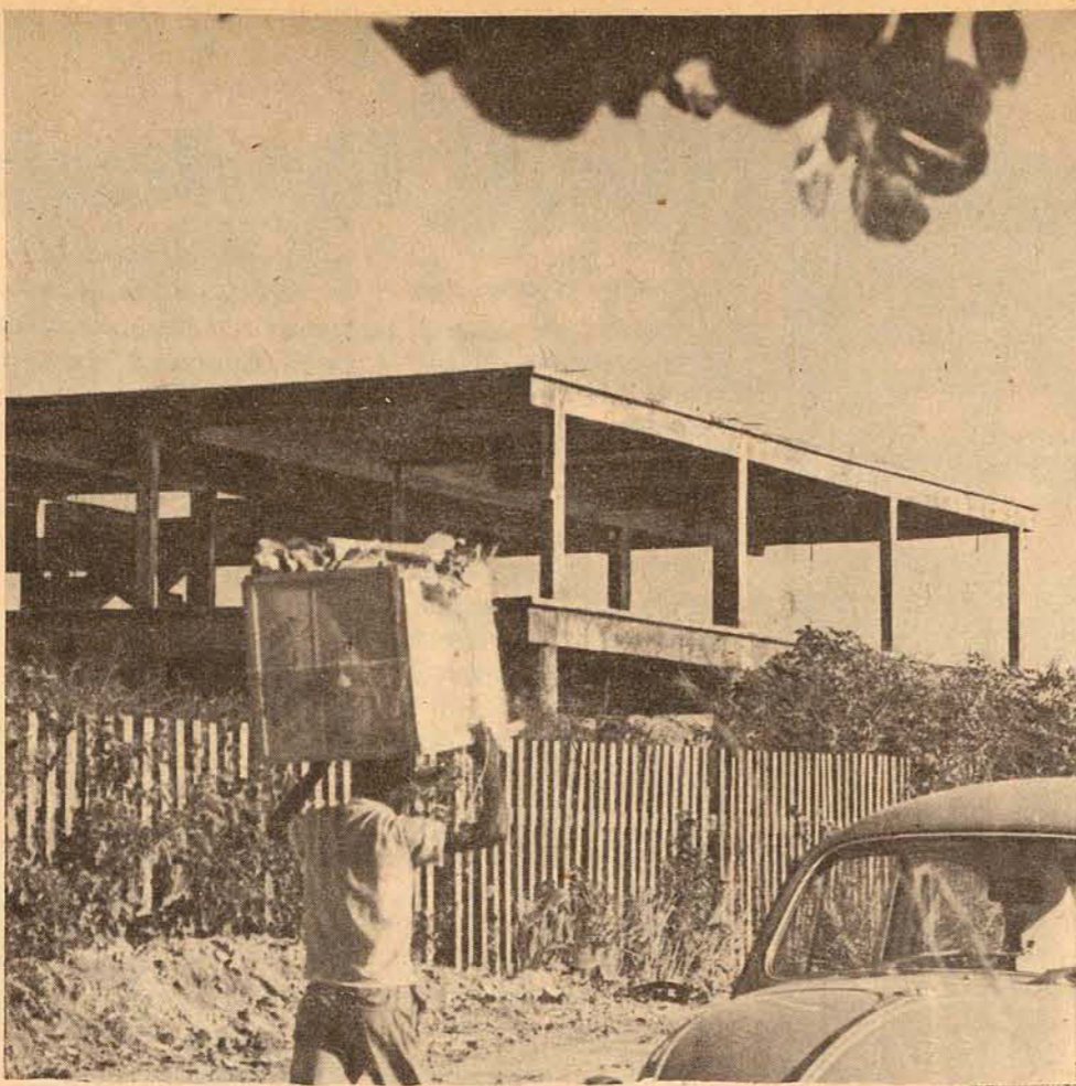
O Governo pensa em localizar a Esag no prédio em construção que lhe foi doado.
