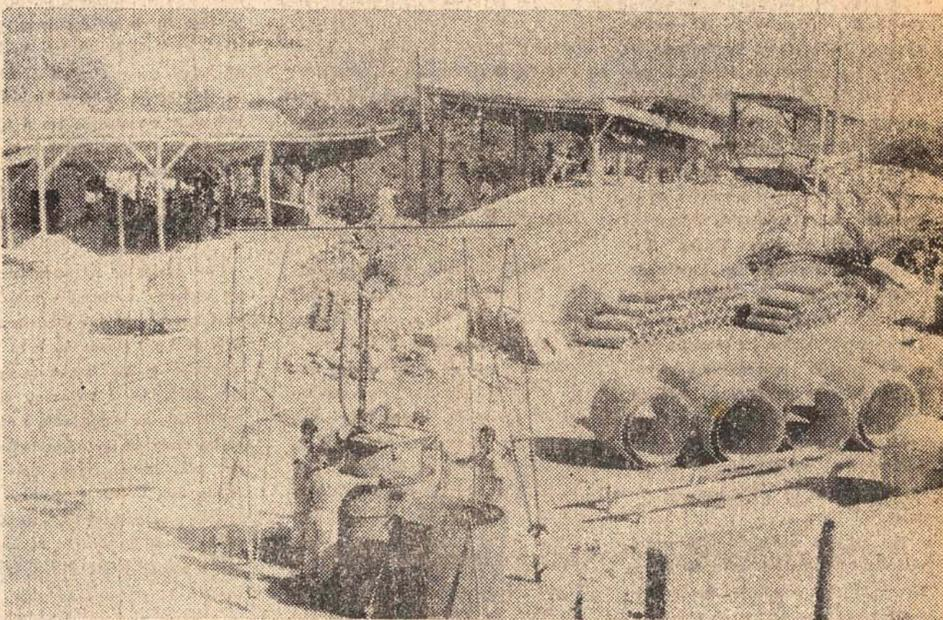
Na Emacim são fabricados tubos armados de 100m e as lajotas que pavimentam as ruas da Cidade
