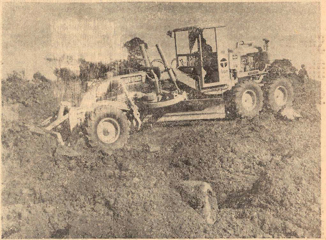
Motoniveladora Huber Warco Modelo 11D, equipada com lâmina bulldozer trabalhando na construção da estrada da Lagôa da Conceição. Obra contratada pela Tersan, com o Governo do Estado.
