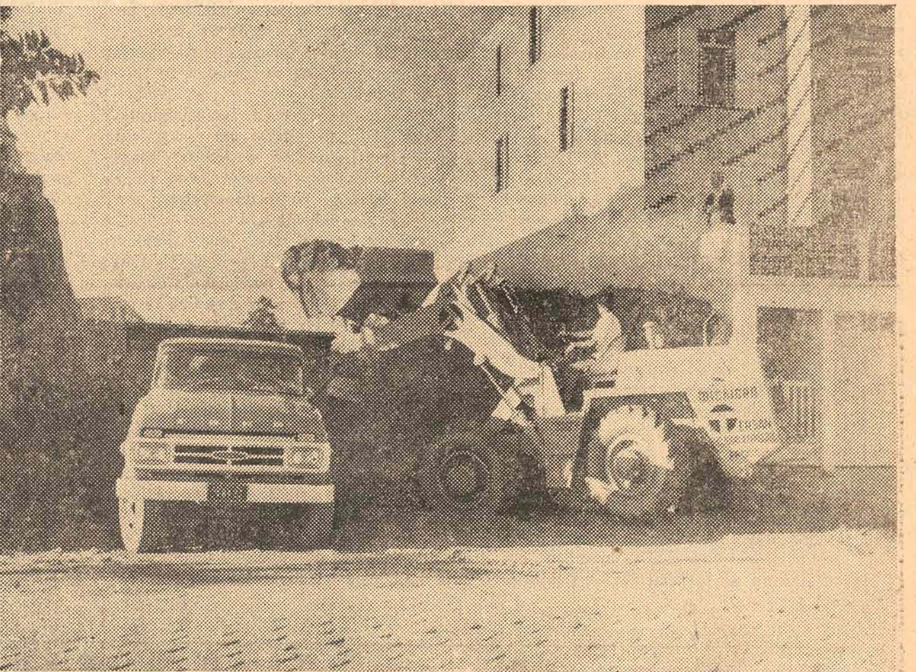
Traçor Escavo Carregador Michigan, modelo 75III de fabricação nacional, trabalhando no centro da cidade, próximo a ponte Hercílio Luz, em mais uma obra contratada pela Tersan, sob a direção do Engº Claudio Valente Ferreira.
