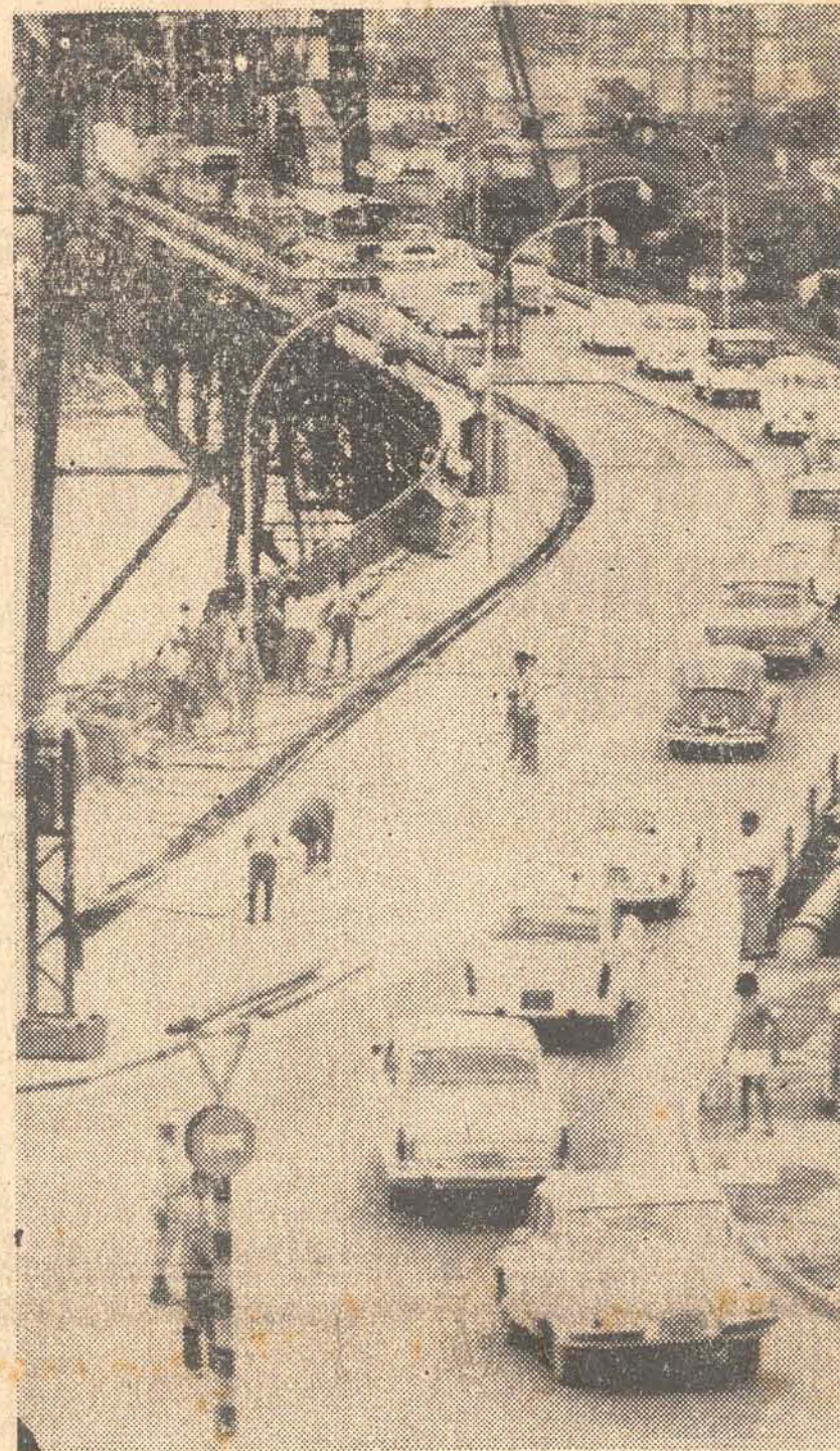
Está prevista para esta semana a conclusão das obras de asfaltamento da ponte
