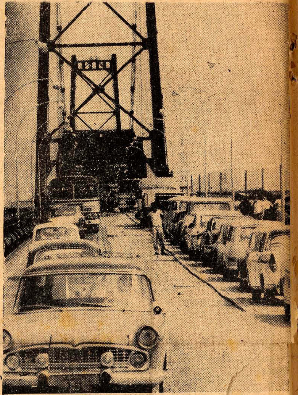
Depois de alguns meses de frégua, a população voltou a sofrer o drama que lhe acarreta as obras da ponte, morosas demais. Filas intermináveis continuam se formando nas horas do "rush".
