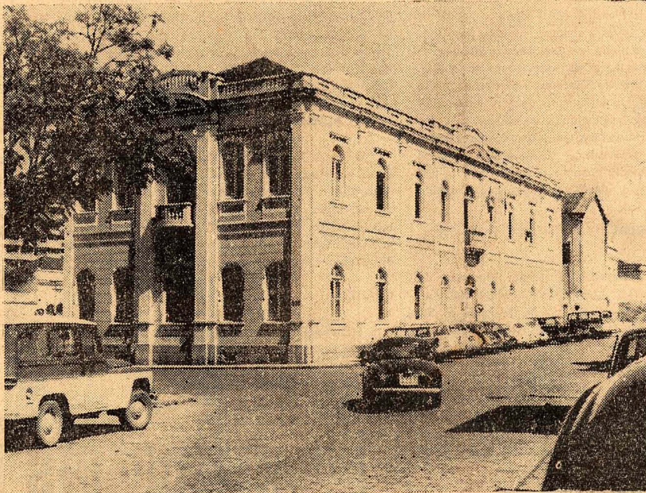
O austero Tribunal de Justiça, começa a pensar na mudança para o prédio onde funcionou a agência Ford, onde se instalará até que fique pronto o novo Palácio da Justiça, provavelmente em janeiro de 1971.
