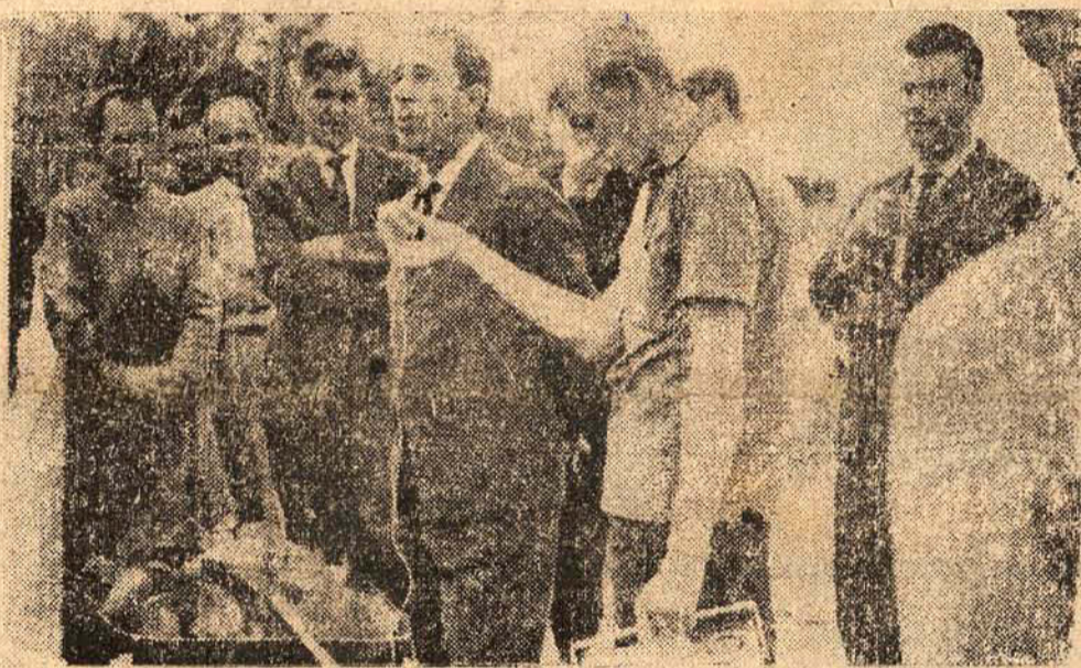
O sr. Alvaro Selva Gentil, Diretor da COHAB-SC lançou em Mafrá a pedra fundamental da vila das casas populares, num total de 100 unidades habitacionais, que serão entregues em breve espaço de tempo. A solenidade estiveram presentes o sr. Raul Leão Niebsch, Prefeito da cidade e o sr. Dalibar Dali Mansur, advogado da COHAB-SC. (leia 8ª página).
