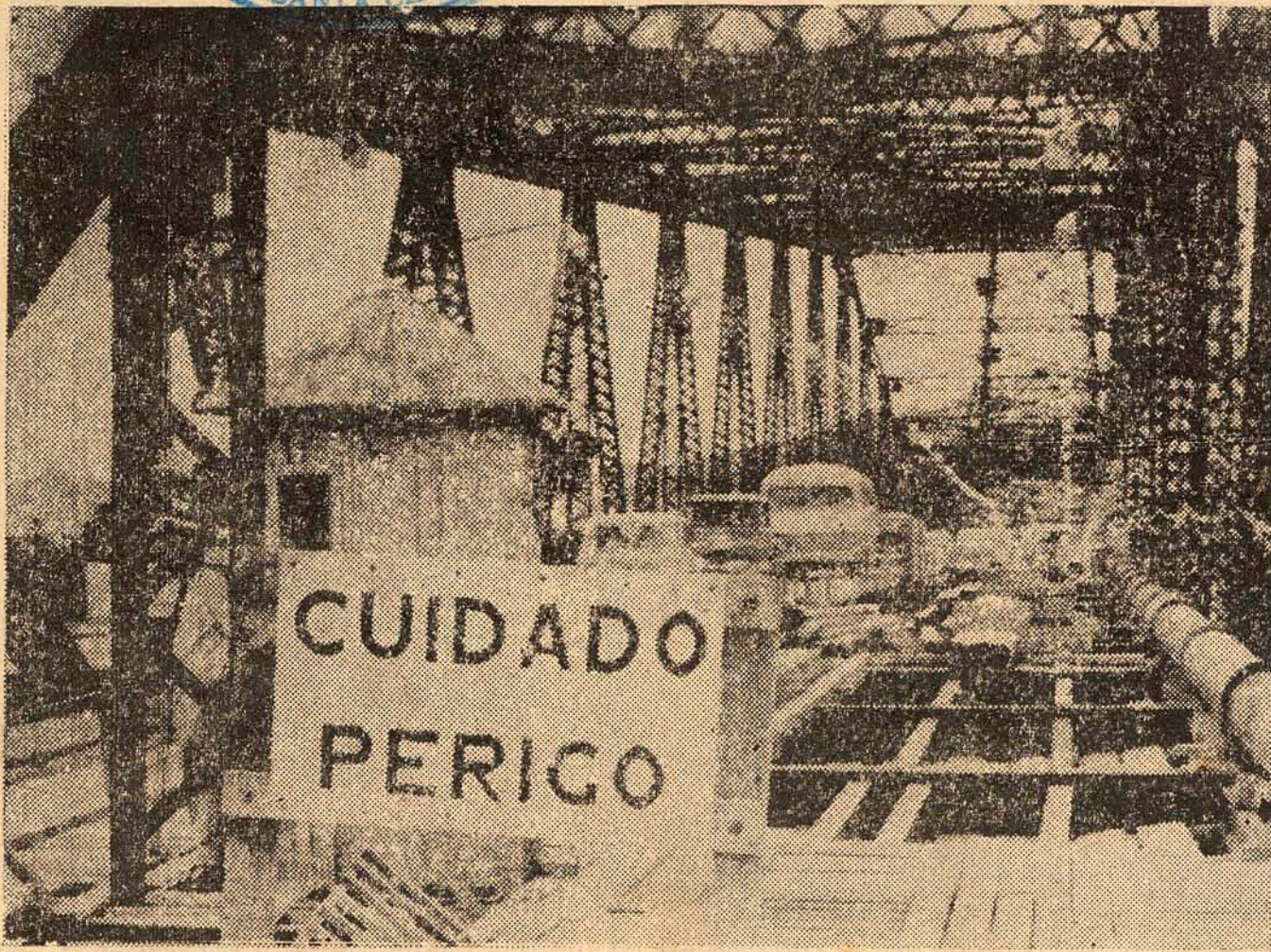
Os motivos da morosidade dos trabalhos de asfaltamento da Ponte Hercílio Luz são explicados na 8a. página de nossa edição pelo diretor do DER, órgão encarregado da execução dos serviços.
