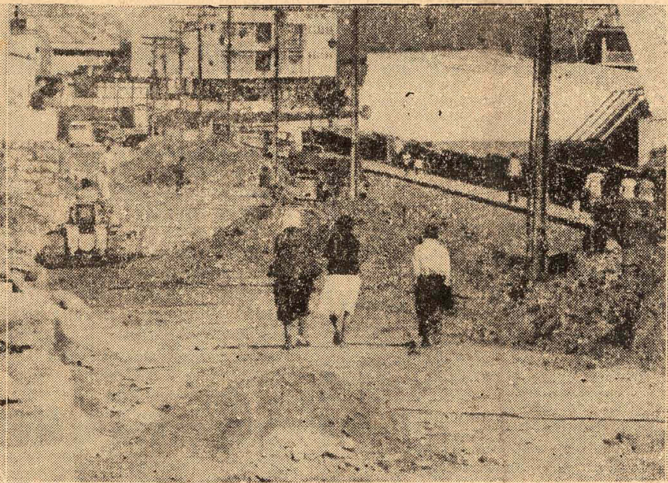
Máquinas e operários dão início à urbanização da segunda via da Avenida Mauro Ramos, no trecho que fica em frente ao Instituto Estadual de Educação.
