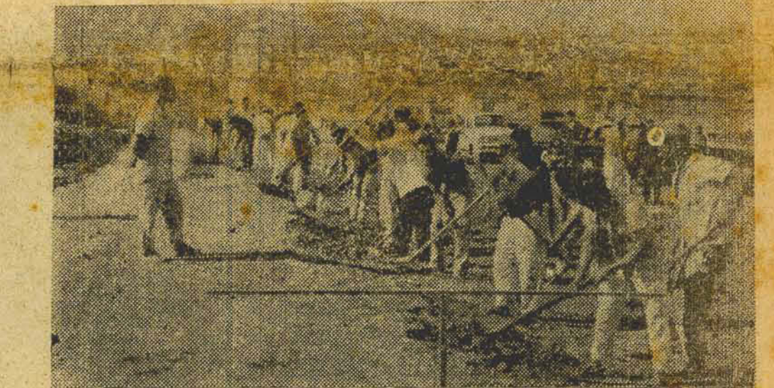
Trabalhadores, sob a supervisão de técnicos da PLAN-ARK (firma encarregada da execução das obras de paisagismo e urbanização) quando executavam as tarefas iniciais no Morro da Ponte. (TEXTO NA 8.ª PÁGINA)
