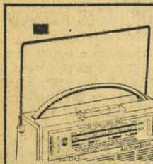
ANTENA DE QUADRO: de efeito direcional, que elimina interferências e assegura sempre melhor recepção em ondas curtas.
