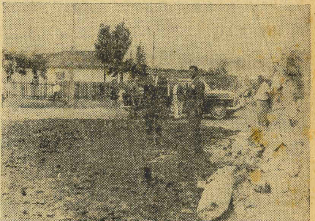
Na foto, o Prefeito Vieira da Rosa, em companhia do Dr. Georges Wildt, Secretário de Investimentos da Prefeitura, inspecionando as obras de calçamento da Rua Professora Antonieta de Barros, no Estreito.
