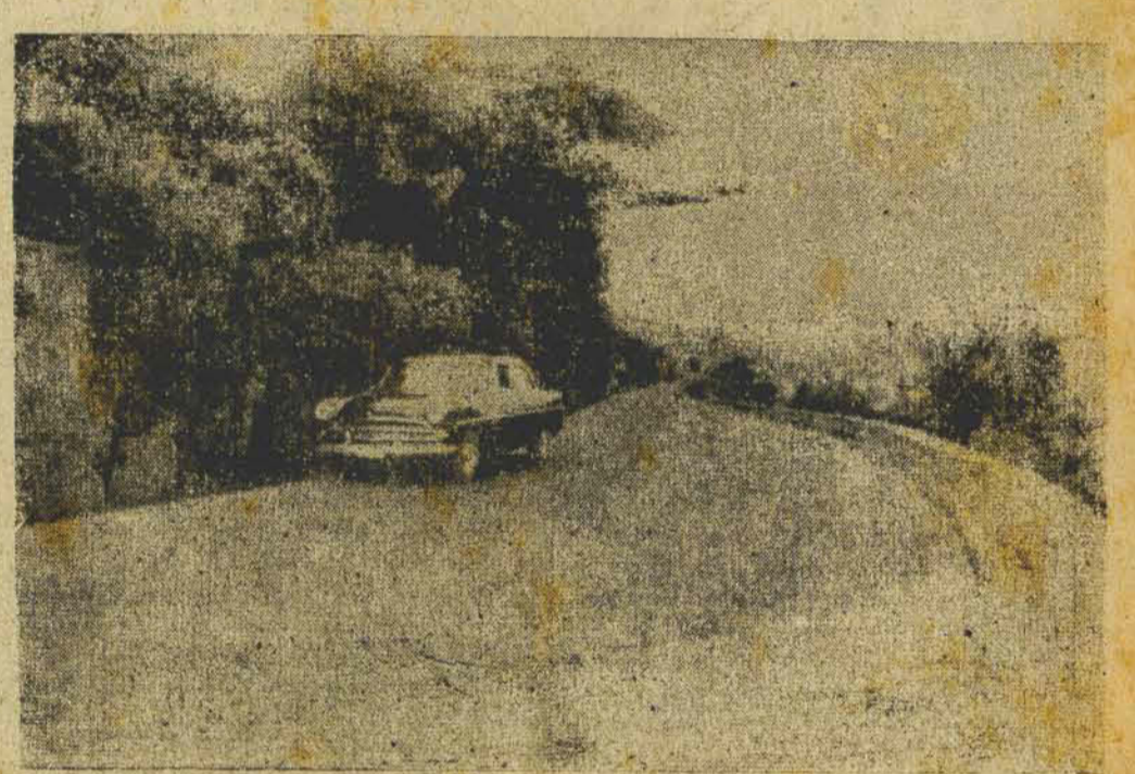
A inauguração do asfaltamento da estrada do aeroporto foi realizada através da CODEC, órgão de As obras foram confiadas a Pavimentadora Manutenção Realização, nesta cidade capital, com a conclusão dos trabalhos da pavimentação asfáltica da estrada que liga o aeroporto ao centro.
