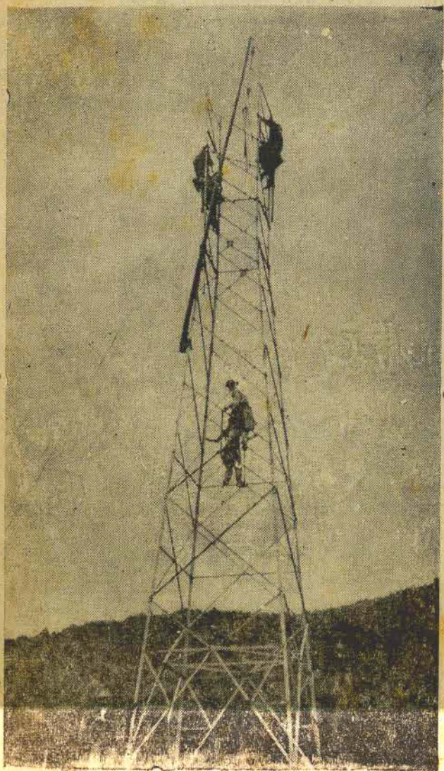
O flagrante mostra a montagem de uma torre metálica. (TEXTO NA 3.ª PÁGINA)
