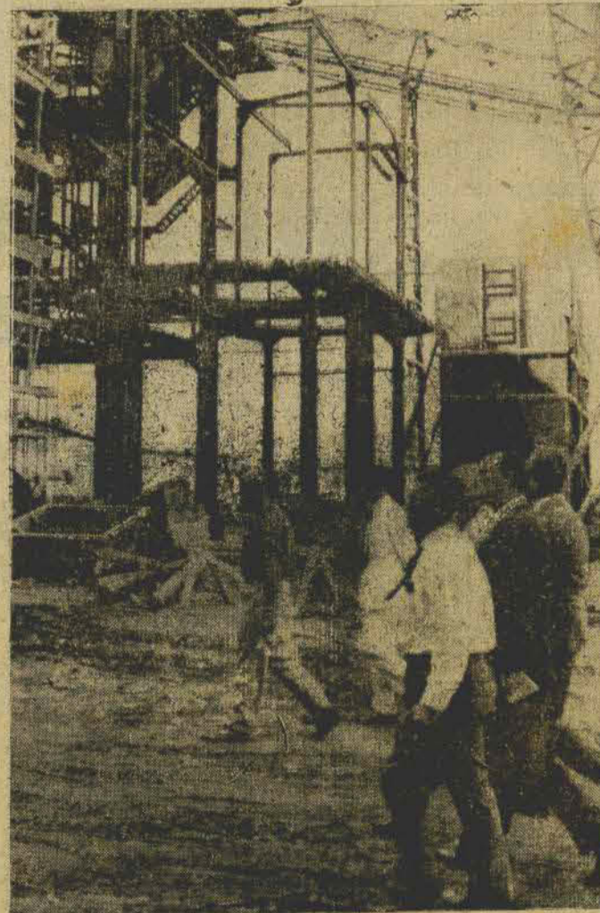
Outro aspecto da visita às obras. A Sotelca terá a sua primeira unidade de 50 mil KW inaugurada em outubro próximo
