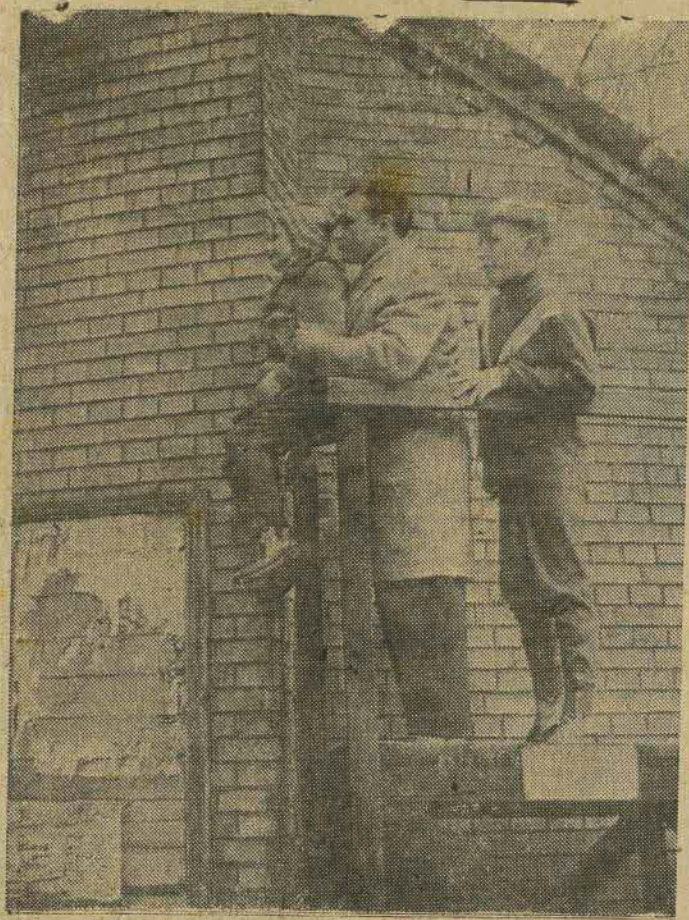
Antigamente a Wollankstrasse era uma das principais vias de comunicação entre os bairros Moabit e Pankow, de Berlim. Hoje está dividida pela muralha construída pelos comunistas e o pósto de observação, que havia sido construído para a polícia do setor ocidental, serve também aos cidadãos deste setor, para que possam ser seus parentes, prisioneiros no setor comunista, após combinarem o local e a hora por carta.
