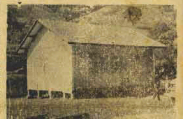
Em Braço Seco, Massaranduba, foi construída OUTRA DAS MIL (foto)
