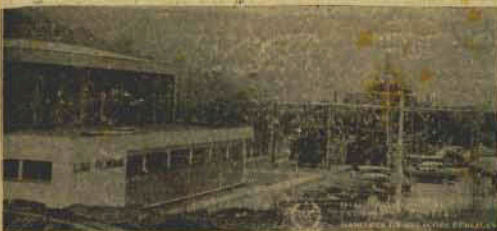
Em aspecto, a Usina Palmeiras, de Blumenau, que será proximamente inaugurada, tornando mais 22 KVA para aquela próspera região do Estado.
