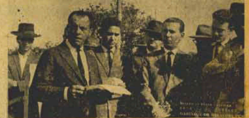
O Dr. Pando de Freitas Neto dirigindo, em nome do Governador, como Presidente da Comissão de Energia Elétrica, as pessoas que presenciaram a inauguração da subestação de Sanga da Toca, cuja linha de transmissão abrange Sombrio, Turvo e Jacinto Machado
