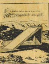
É a imensa estrutura de concreto e aço é um telescópio solar que está em fase final de construção. No cume de uma montanha no sudeste dos Estados Unidos os raios solares do telescópio se e refletirão pelo túnel em diagonal de 146 metros por meio de uma série de espelhos até atingirem um observatório subterrâneo. Seu comprimento será de 100 metros e sua abertura uma lâmina de 25 centímetros de sol.
