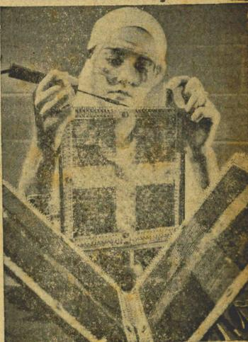
Assemelhando-se a um tear de teletip, que este tecido em eletrônico está realmente fazendo e terminando um plano de "memória" para um cérebro eletrônico. Feito na fábrica da RCA em Needham, Massachusetts, o plano se combina com 13 outras para armazenar dados necessários para o sistema de processamento de dados do cérebro eletrônico RCA 301, usado para solucionar complexos problemas a altas velocidades.
