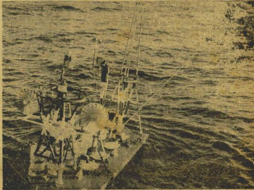
Esta é a estação meteorológica flutuante "Nomad I", do Golfo do México, que transmite, cada hora, as mudanças verificadas na atmosfera e no mar. É dotada de equipamento eletrônico e de transmissores automáticos de ondas curtas.
