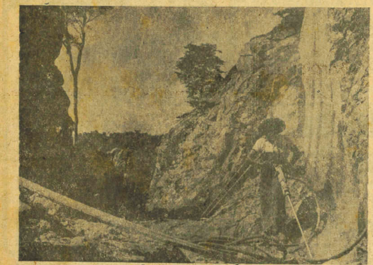
Aspectos colhidos por ocasião da visita dos Diretores da CELESC às obras em andamento da Usina do Espirinha.
