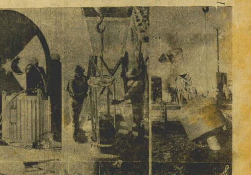
O Serviço de Guarda Costas da Marinha dos Estados Unidos colocou à entrada da baía de Balneario um "farol atômico", capaz de funcionar ininterruptamente durante dez anos sem necessidade de reabastecimento de combustível. Nas fotos, detalhes deste novo instrumento de proteção à navegação: à esquerda, o gerador termoeletrônico montado a estrôncio-90; ao centro, a bateria e o transformador de voltagem; à direita, o farol atômico, já inteiramente equipado, e colocado na entrada da baía.
