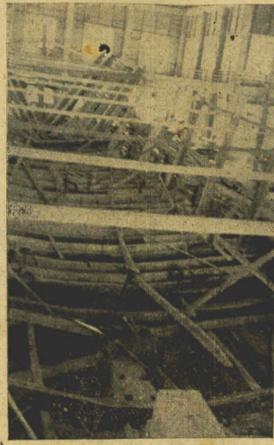
Está sendo construído nos Estaleiros do 5º Distrito Naval, em Coqueiros, um barco destinado ao carregamento de torpedos e que cumprirá sua missão na Baía da Guanabara. O Barco tem os seguintes detalhes técnicos: 20,30 metros de comprimento; sistema de água; 2 tons de pontal; 1,30 ms. catado; destoca 56 toneladas. Tem capacidade para carregar 22 toneladas. O Barco, cujo casco aparece na foto, foi encomendado pelo Centro de Armamento da Marinha.
