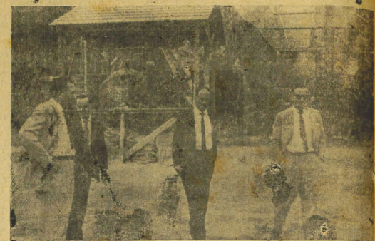
Deputado Osni Régis, Secretário da Viação e Obras Públicas, deputado Jota Gonçalves, Dr. Mário Garcia, Eng. Chefe da Residência do DER de Joinville e Dr. Alvaro Gaioso Neves, Eng. Chefe do Entu, firma contratante da rodovia Joinville-São Francisco, durante a visita realizada ao local onde se encontram máquinas da firma.
