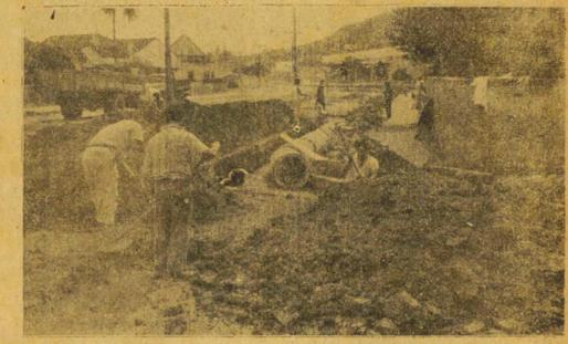
Equipe de operários da DOP trabalham ininterruptamente preparando o terreno, abrindo valas para a instalação dos tubos que canalizarão a água que desce dos morros, antes de iniciado o trabalho de calçamento.
