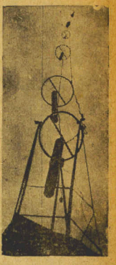
Nesta foto, tomada de balão para cima, vê-se, presa ao balão, a estrutura, onde estão ajustadas as cargas explosivas
