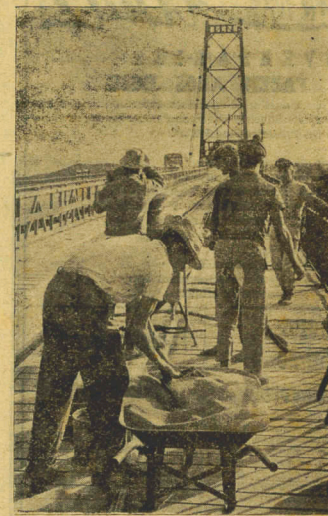
Já foram reiniciados os trabalhos de recuperação da Ponte Hercílio Luz, para a qual o Governador Celso Ramos pedira prioridade.
