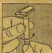
4 - Para barbear, feche o aparelho girando a extremidade do cabo para a direita.
